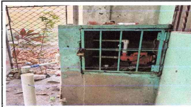
Foto 4: Sustitución de una bomba de agua 1"
