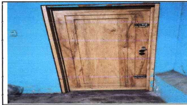
Foto 6: Sustitución de 1 puerta de madera por metal
