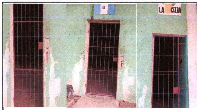
Foto 8: Mantenimiento de estructuras (lijado, cambio de tubo, cepillado, sujeciones, aplicación de pintura)
