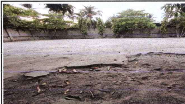
Foto 2: Sustitución de piso de concreto por piso de concreto 345 mts x 80
