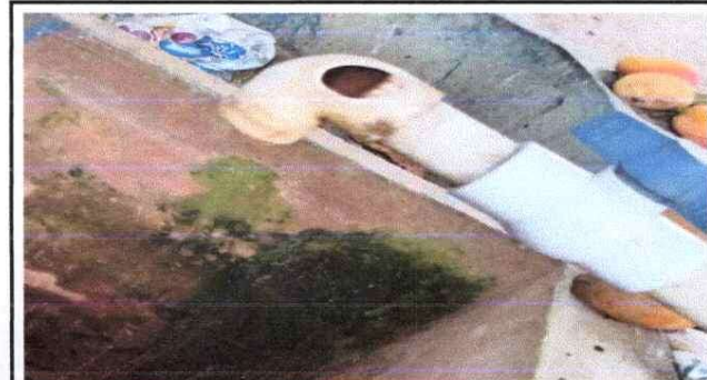
Foto 10: Sustrucción de llave de chorro
