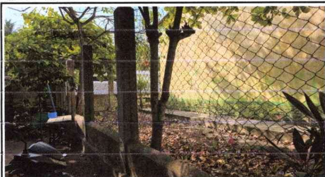
Foto 1: Reparación de tubo hg y malla galvanizada
