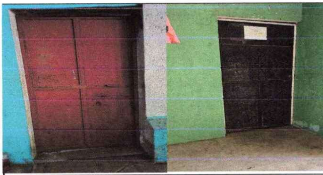
Foto 5: Sustitución de 2 puertas de metal por metal
